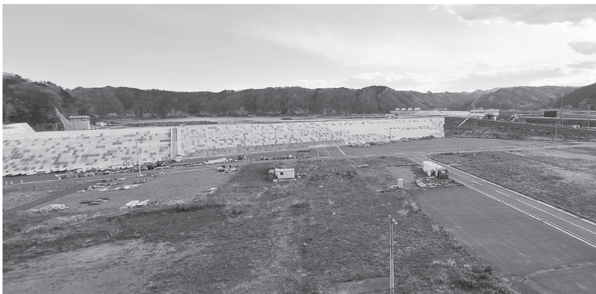
津波で破壊された海側の防潮堤に替わり、新たに設けられた高さ 14.7m の防潮堤。新防潮堤建設と併せ、田老地区では住宅地の高台への移設も行われた。(2022 年 5 月、三木剛氏撮影)
