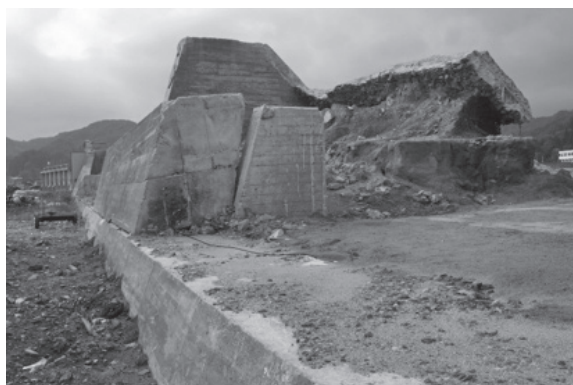
海側の防潮堤の津波被害断面。土手状に土で盛土し、その外周を比較的急勾配の鉄筋コンクリート造の壁で覆っている。
