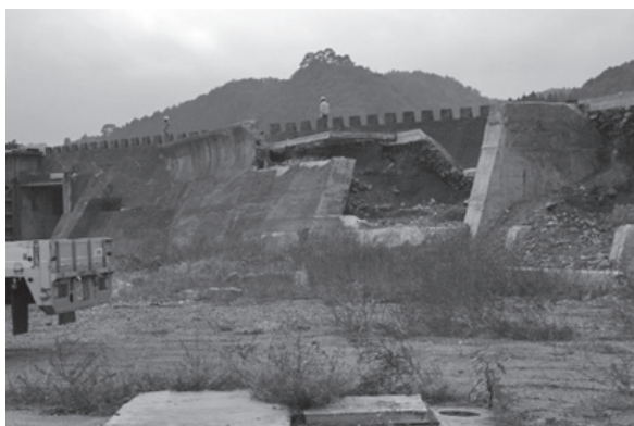
1934年から50年近くの歳月をかけて築かれた田老の防潮堤。明治、昭和と続けて大津波による壊滅的被害を受け、「万里の長城」と呼ばれる長大な防潮堤が設けられた。
