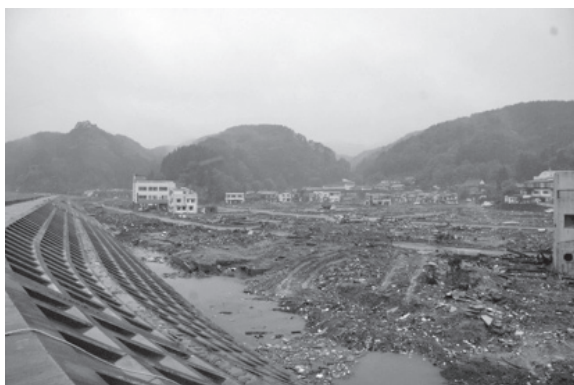
総延長 2433 m、高さ 10 m の防潮堤の山側ウイング上部より市街地側を見る。木造家屋は全壊し瓦礫と化してしまった。鉄筋コンクリート造の建物はサッシや外壁は被害を受けたが主要構造部は残っている。防潮堤が田老の建物を津波から守ったとは言えない。
