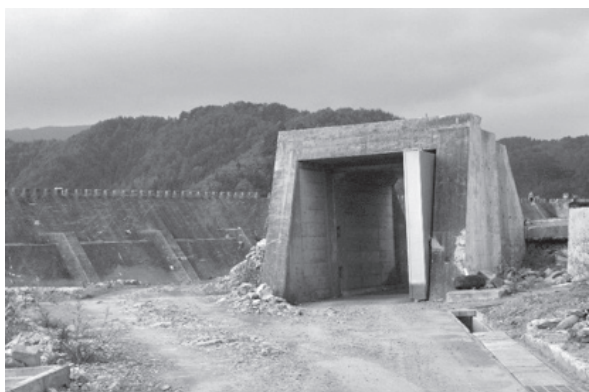
1934年から50年近くの歳月をかけて築かれた田老の防潮堤。明治、昭和と続けて大津波による壊滅的被害を受け、「万里の長城」と呼ばれる長大な防潮堤が設けられた。
