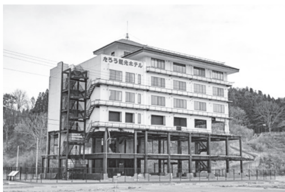
東日本大震災により3階まで浸水し、1階と2階は完全に破壊されてしまった「たろう観光ホテル」。
