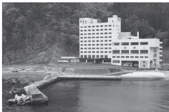
復旧工事後の羅賀荘外観。3階まで津波を受けた。 左側の低層棟は除却され、右側塔屋が増築されている。恐らくライフライン設備を上層階に移設したものと思われる。
