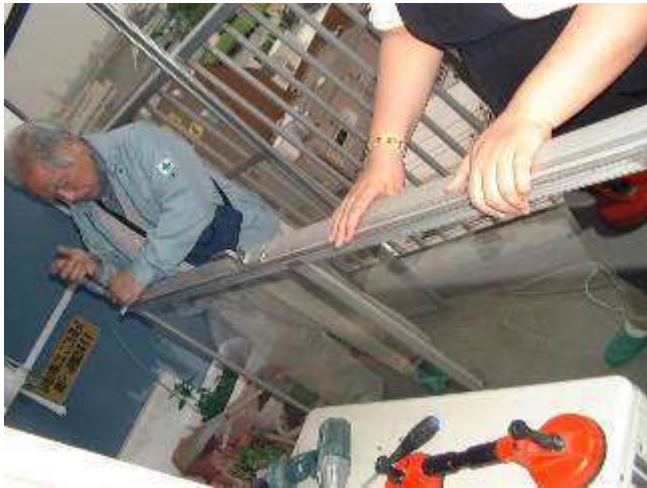
既存サッシは框を外し、付属金物を取替え、アルミ押出型材は清掃し、点蝕防止コーティングする。
