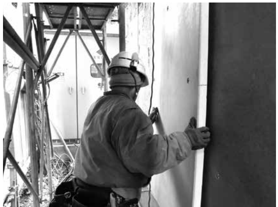
外壁に GRC 複合の断熱パネル(厚さ 9mm+40mm)を貼り、オルガノポリシロキサン塗装仕上げとする。
