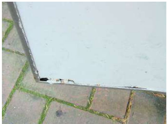
扉の周囲にステンレス製の縁を付けた鋼製扉 鉄とステンレスの隙間に雨水が浸入し、鉄が錆びて穴が開いている。
