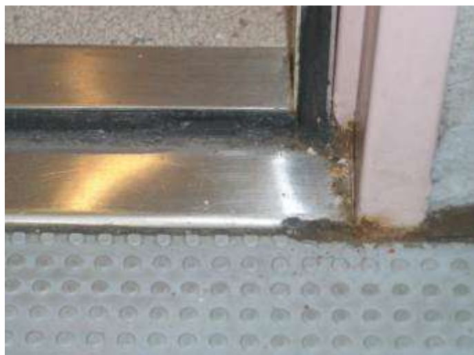
腐食劣化し、枠ごと取替える必要がある鋼製・玄関扉
