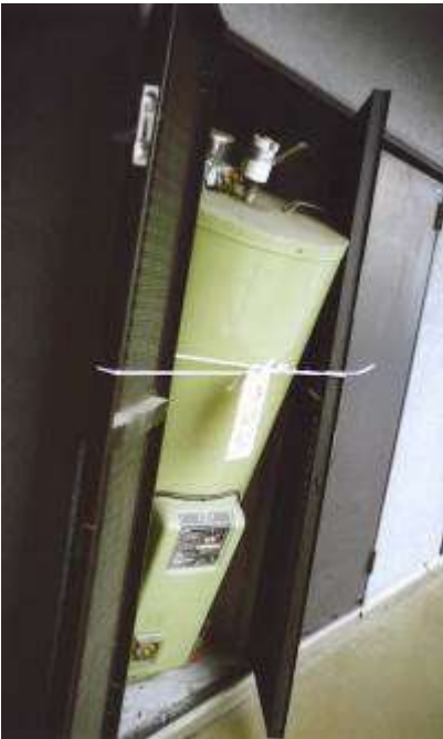
左の写真は阪神大震災で転倒した貯湯式・深夜電力・給湯器。右の写真は、福岡沖地震で転倒したエコキュート。貯湯量：400ℓ、温度：85℃、の熱湯が入った貯湯槽が、震度5の地域でも転倒し、建物内がお湯浸しとなる。
