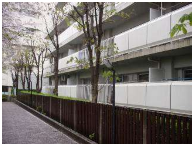
バルコニー側の二次部材：各戸の掃出しサッシと手摺パネル、隣戸隔板、物干金物、垂直避難口で構成される。
