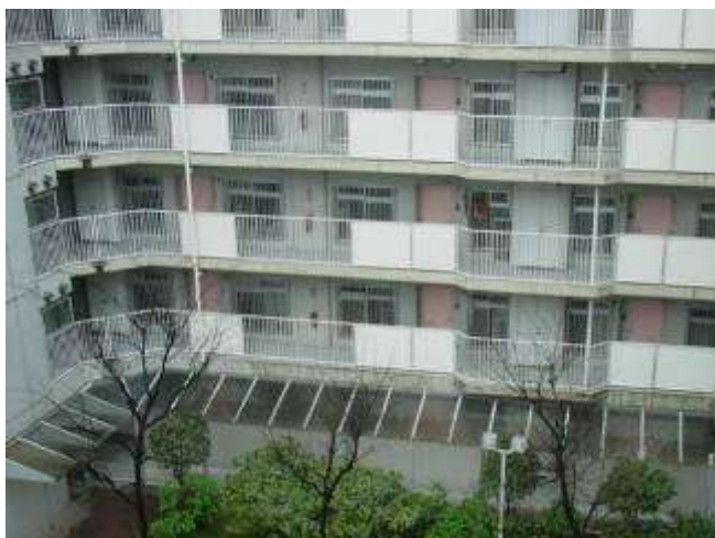
共用廊下側の二次部材：各戸の窓サッシには面格子が付き、鋼製玄関扉の上部には排気孔キャップが付く。パイプシャフト・メーターボックスは鋼板パネル扉で形成されている。手摺は鋼製パネル、ユニットで構成され、手摺の上部には防風スクリーンが設けられ、1階共用廊下はポリカーボネート樹脂の屋根庇が見られる。
