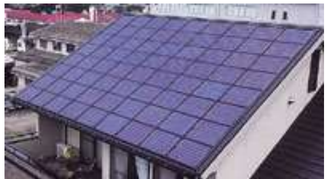
屋根葺き材兼用タイプのソーラーパネル
