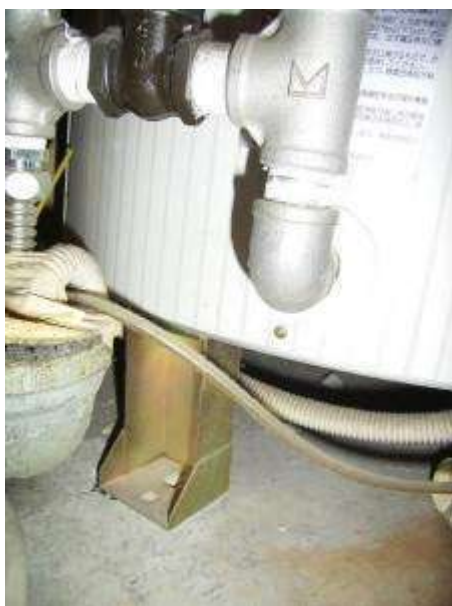
床固定用のアンカーボルトがない。 床の3点で固定する必要がある。
