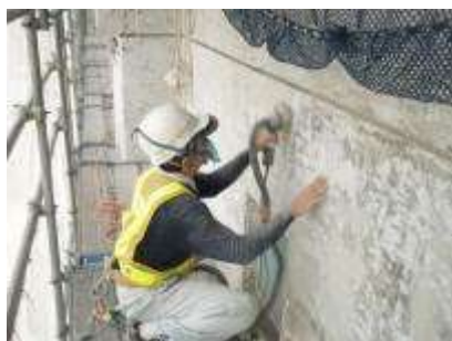
カップリングで段差修正をする
