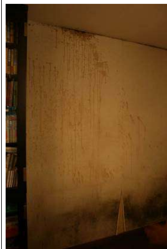
住戸内の結露被害 多摩ニュータウン
