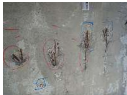
鉄筋爆裂を補修する
