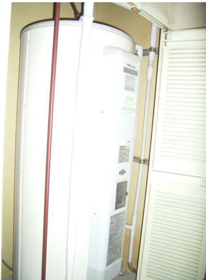
室内の廊下に面して設置された貯湯式深夜電力温水器。
