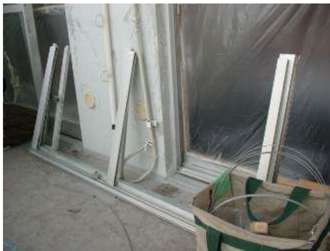
外した障子の框をクリーニングした後、組立てて復旧し、新品の付属金物を取付ける。
