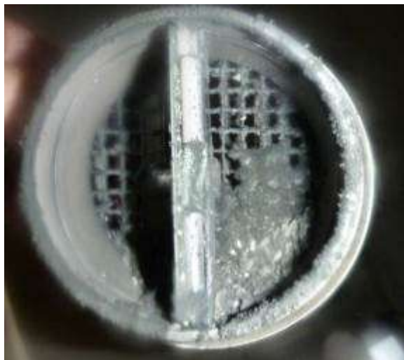
便所・洗面所系ダクト吸気口周りの閉塞状況
