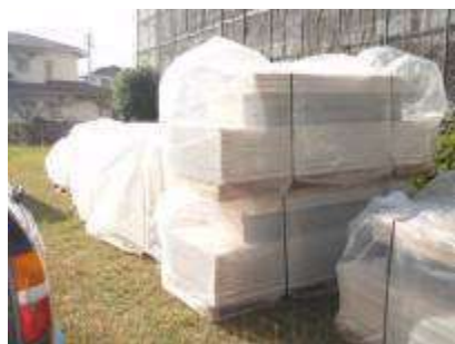
現場搬入された外断熱パネル
