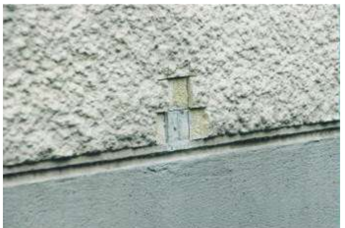
自発泡型アルミナセメント吹付け塗材による外断熱 自発泡のパターンが荒く、美装性に欠ける。販売停止。
