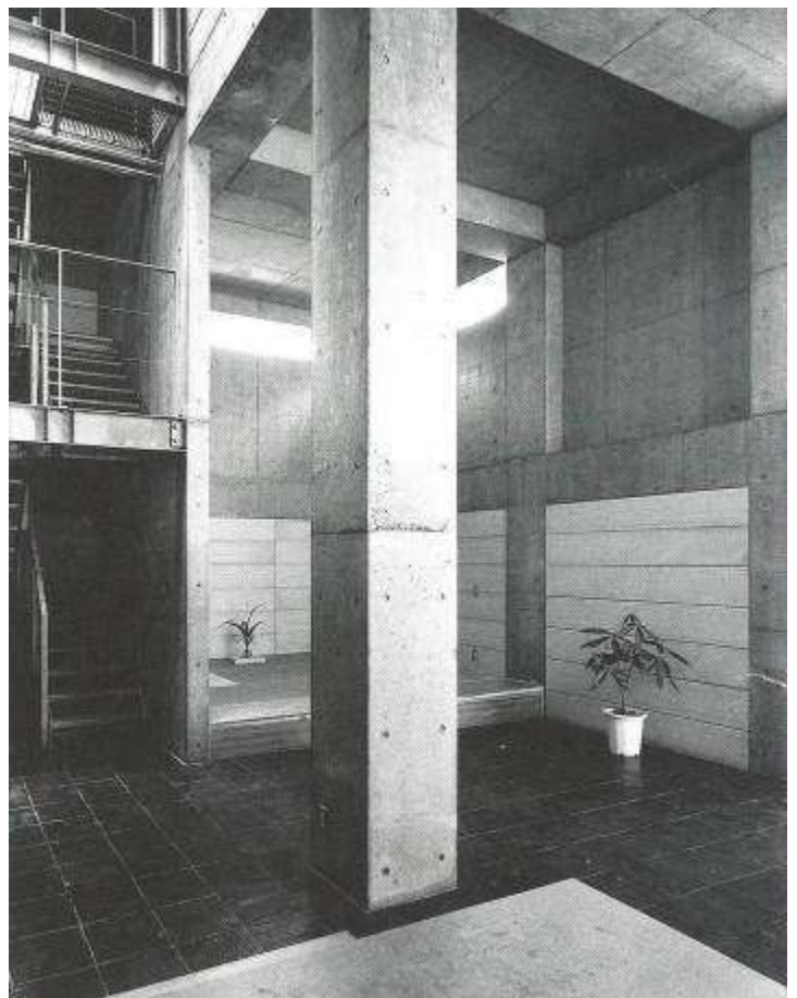
リビングルームの大黒柱。奥は和室と鉄骨階段・上部天窓 床は床暖房+玄硝石張り。冬の陽射が床を暖める。
