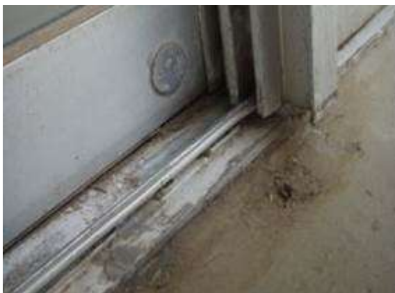
擦り減り変形したアルミサッシのレール
