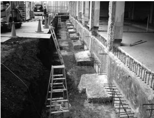
アウトフレームの基礎工事。既存建物の根切り底に合わせた基礎工事。地下は雨水貯留槽として活用する。
