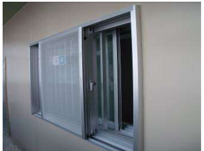
二重サッシ間に面格子。外断熱パネルを貼り仕上げる
