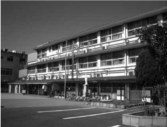
改修前の小百合の寮の南東側外観。空調室外機が底の上に置かれ、外壁に設備配管が露出していた。
