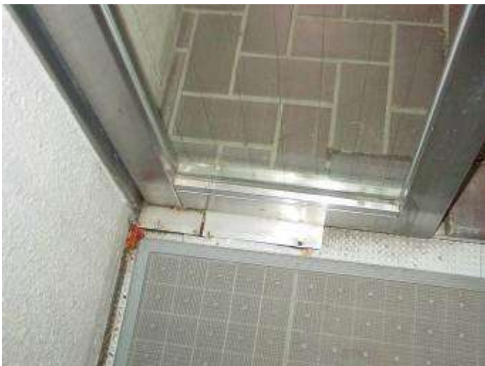
フローアヒンジの内部に雨水が浸入し、開閉不能になったステンレス製框扉
