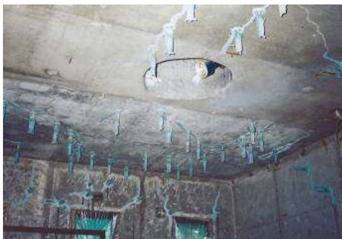
内装材を剥がし躯体のひび割れにエポキシ樹脂を注入 中性化抑止材を十分に塗布、含浸させる。
