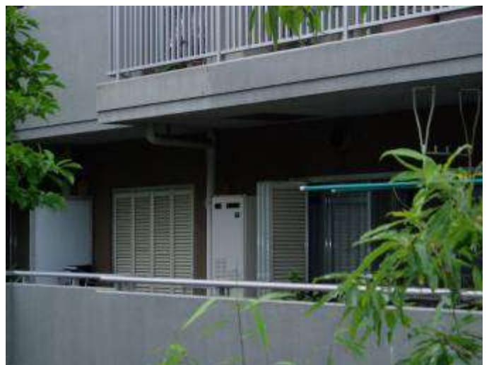
既存サッシの外側に錠戸を取付けて防犯性を高めた1階住戸
