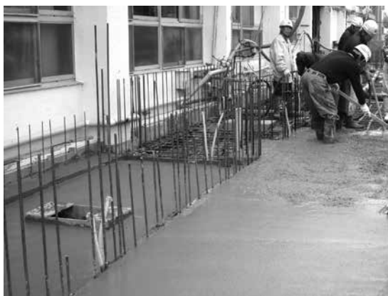
既存建物と EXP.Joint で、躯体の縁を切り増築棟の2階スラブのコンクリートを打設する。
