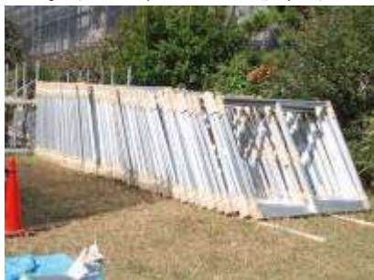
現場搬入された新規外付サッシ枠
