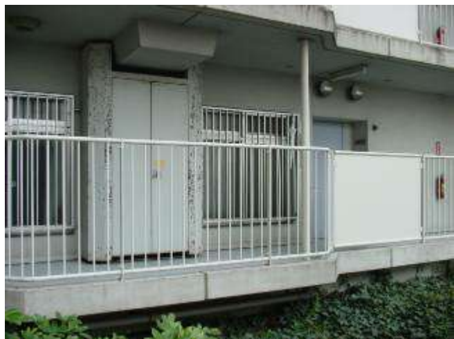
共用廊下側の二次部材：各戸の窓サッシには面格子が付き、鋼製玄関扉の上部には排気孔キャップが付く。パイプシャフト・メーターボックスは鋼板パネル扉で形成されている。手摺は鋼製パネル、ユニットで構成され、手摺の上部には防風スクリーンが設けられ、1階共用廊下はポリカーボネート樹脂の屋根庇が見られる。
