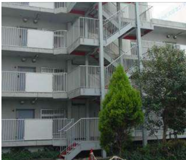
鉄骨避難階段：共用廊下に付設された横森式鉄骨階段。
