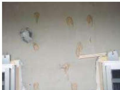
接着剤を壁面に塗布する
