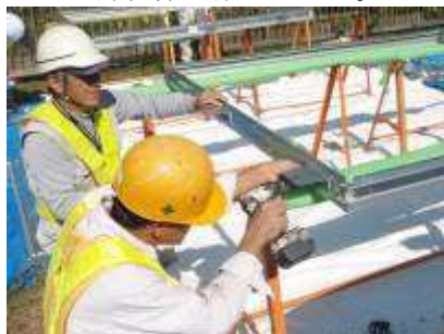
新規枠にブラケットを取付ける
