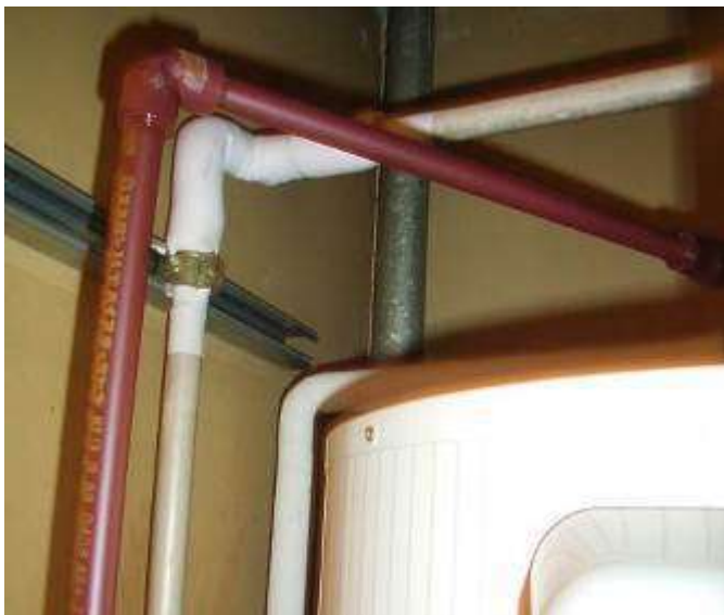
温水器の上部に配管。奥に排水管が見える。
