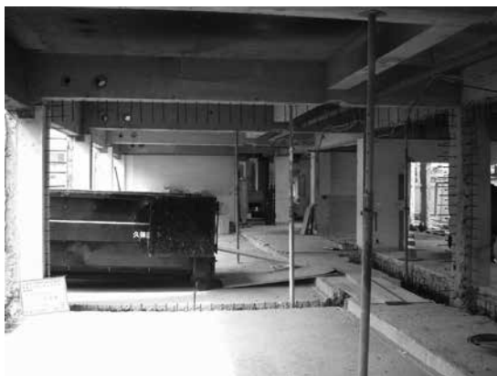
内装材を除去し、躯体を現し鉄筋露筋・ひび割れ・欠損など不具合箇所を補修して耐久性を向上する。
