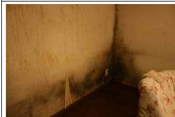
住戸内の結露被害 多摩ニュータウン
