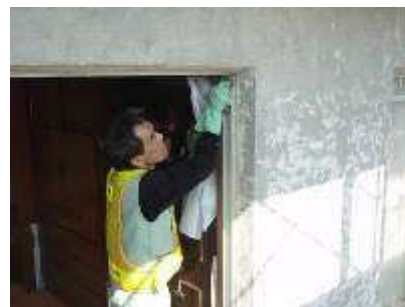
既存枠廻りを研磨清掃する
