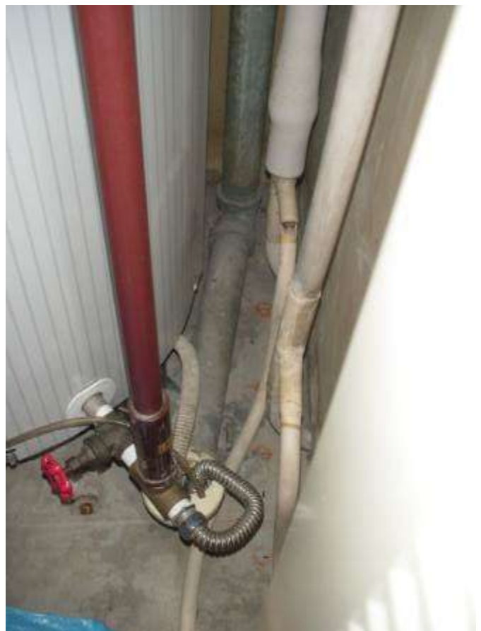
温水器の手前・脇の排水口と排水縦管(奥)
