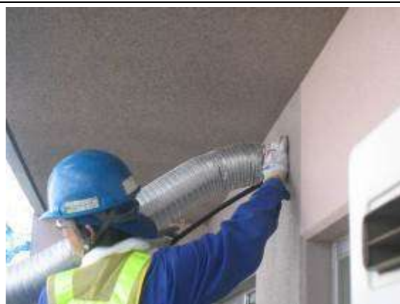
換気扇ダクトの清掃工事。 外壁のベンドキャップを外し、ダクト内の粉塵を吸い取る。
