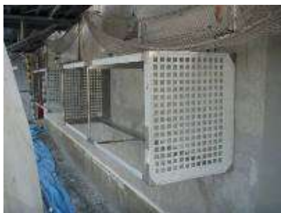
空調室外機置場を取付ける
