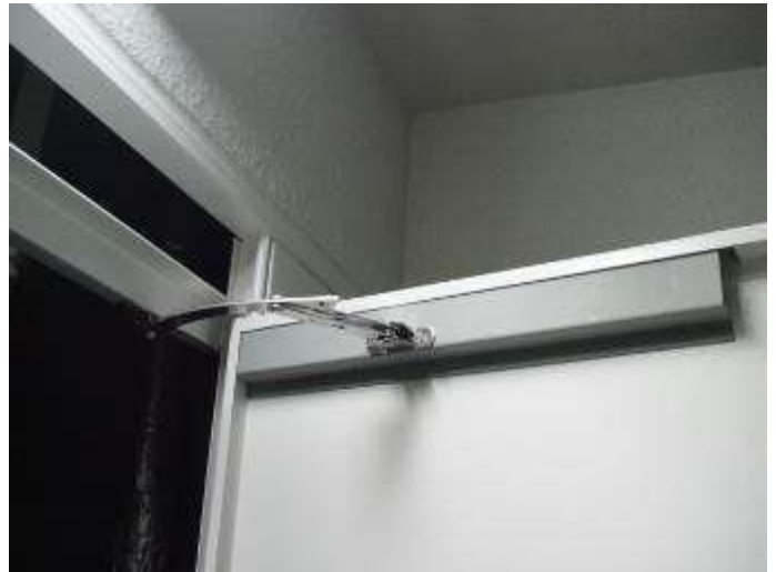
高層階のパイプシャフト扉は、風で煽られて変形したものが多。煽り止め金物を設置する。
