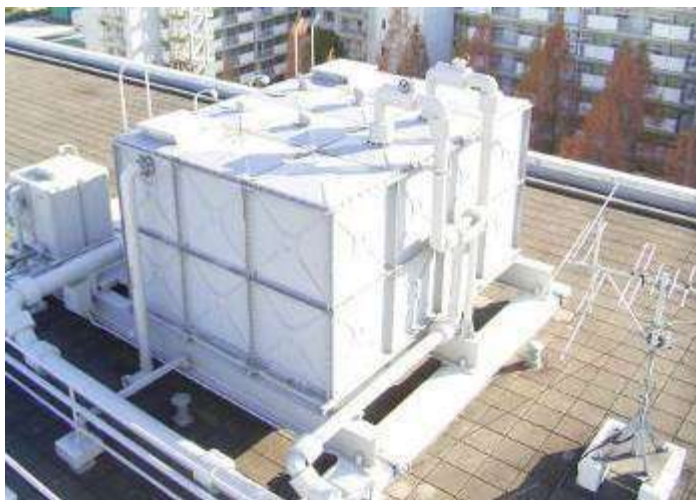
写真の左は今回工事で更新した消防用補給水槽。
