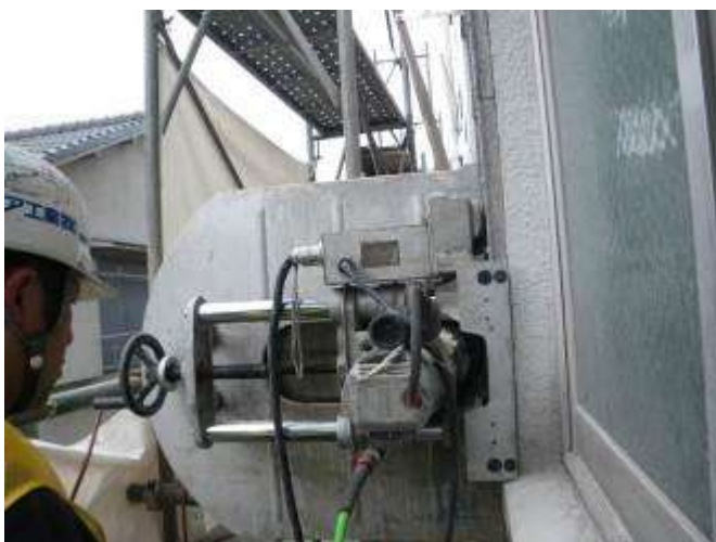
耐震スリットの切断
