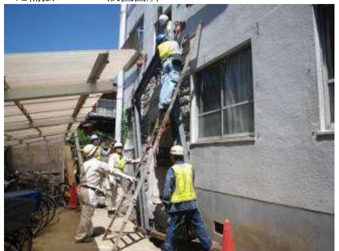
敷地に余裕が無い為、鉄骨建て方に重機を使用できない箇所があり、施工は難航した
