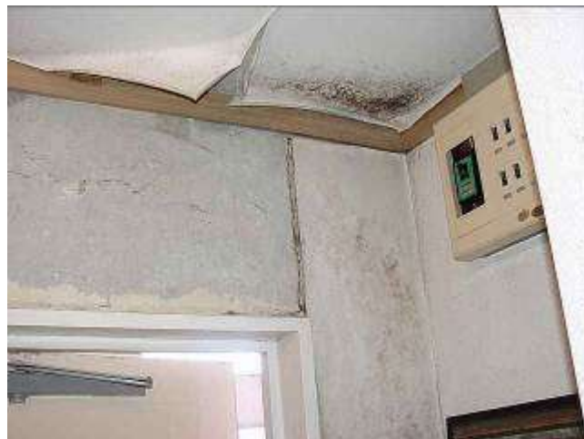
玄関扉上部の壁、及び天井の結露による壁紙の剥離、カビの発生。天井面には断熱材は張られていない。
