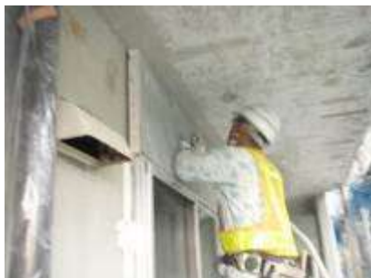
断熱パネルを貼り、不陸調整する
