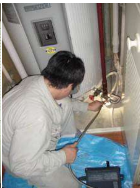
排水ドレインを点検する。 排湯管内の洗浄・清掃をする。
