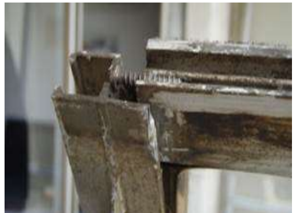
堅枠と横枠を繋いでいる部品が破損し、型崩れしている
