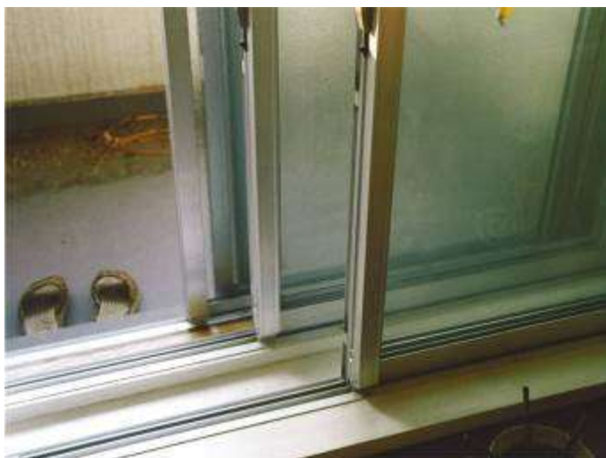
既存サッシの室内側にインナーサッシを付設し性能を向上
