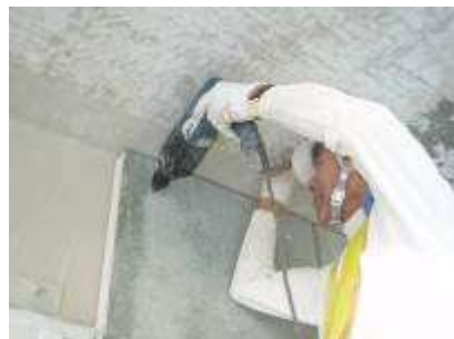
壁面にアンカー固定する
