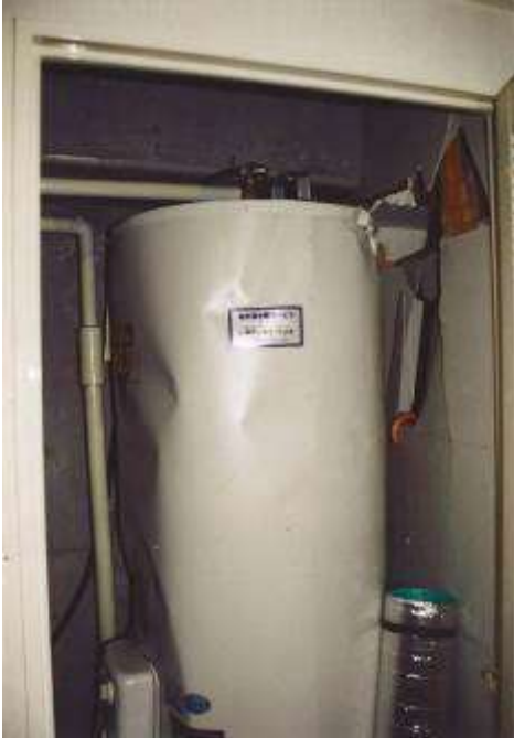
左の写真は阪神大震災で転倒した貯湯式・深夜電力・給湯器。右の写真は、福岡沖地震で転倒したエコキュート。貯湯量：400ℓ、温度：85℃、の熱湯が入った貯湯槽が、震度5の地域でも転倒し、建物内がお湯浸しとなる。
