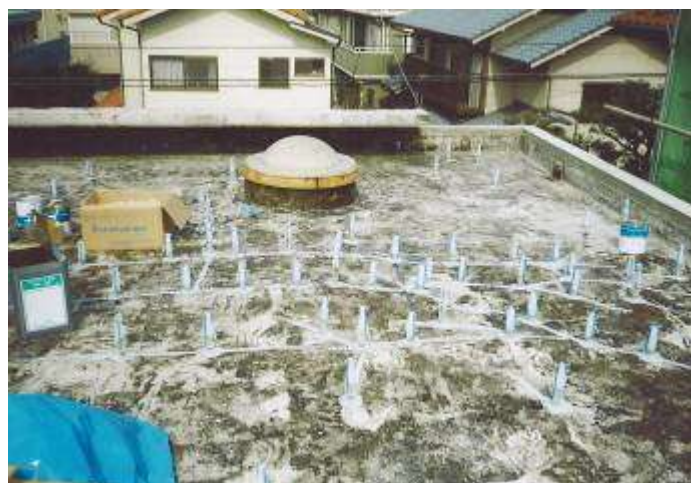
アスファルト防水を剥がした屋根スラブ。直達日射の熱 応力でひび割れが特に多く発生している。
