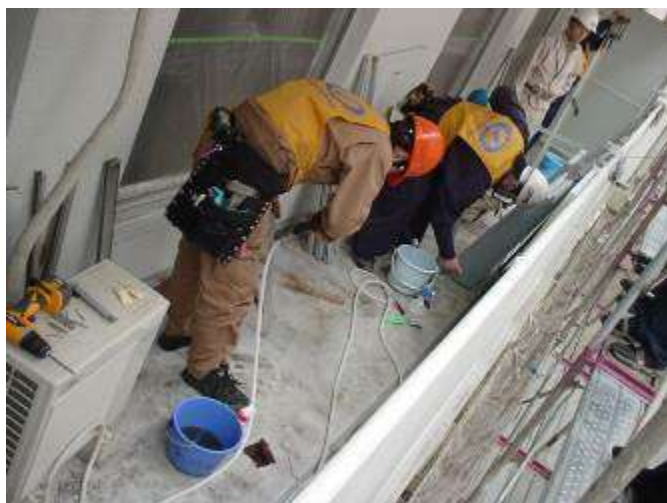
洗浄後、新品の気密ゴム・ガラスビードなどを取付、新品の戸車・クレセントなどの金物を取付ける。
