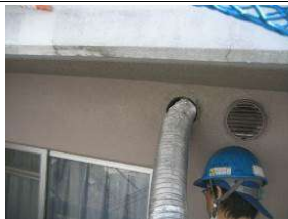
換気扇ダクトの清掃工事。 外壁のベンドキャップを外し、ダクト内の粉塵を吸い取る。
