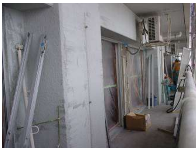
サッシの障子を外し、障子の框を外す。工事中の埃が住戸のサッシを分解し修繕・清掃した人らない様に開口部をビニールで養生する。
