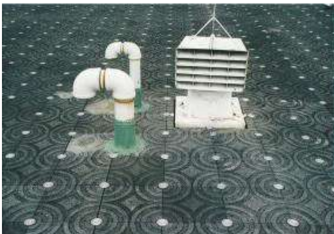
PC住棟は第一回大規模修繕工事で、改質ゴムアスファルト防水、断熱ブロック押え工法で改修した。
