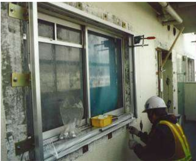
既存サッシの外側に新規サッシを取り付ける。
