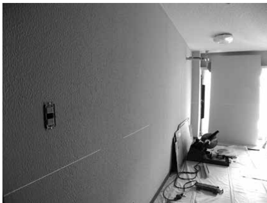
室内側の壁には内断熱・防露処理をせずに、珪藻土塗装とする。開口部は断熱サッシを使用する。
