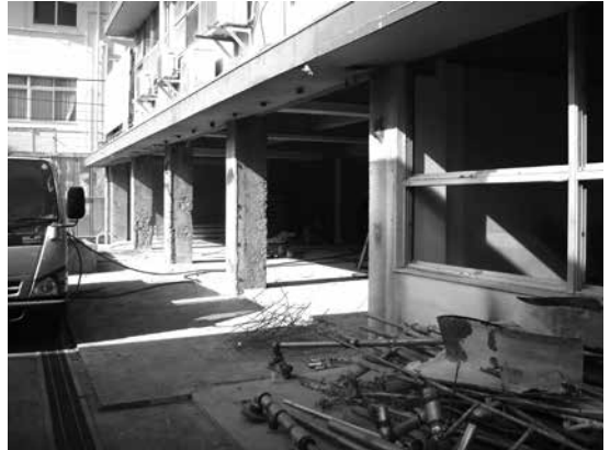
内装材を除去し、躯体の不具合箇所を補修して耐久性を向上する。
