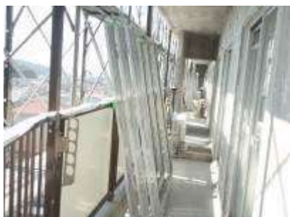
新規枠をバルコニーに仮置きする
