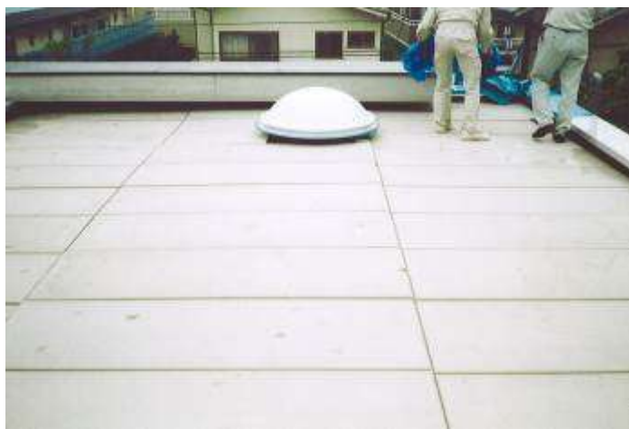
改修後の屋根。改質ゴムアスファルト防水の上、押出発泡ポリスチレン断熱材(厚:50mm)、ALC板(厚:50mm)押さえた。
