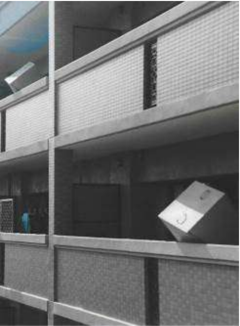
左の写真は阪神大震災で転倒した貯湯式・深夜電力・給湯器。右の写真は、福岡沖地震で転倒したエコキュート。貯湯量：400ℓ、温度：85℃、の熱湯が入った貯湯槽が、震度5の地域でも転倒し、建物内がお湯浸しとなる。
