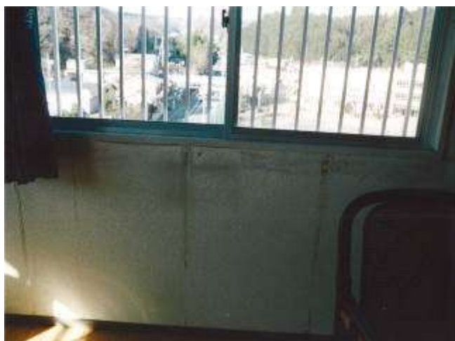
室内の北側・窓下の内壁面に結露によるカビの発生とビニールクロスの剥れが見られる。
