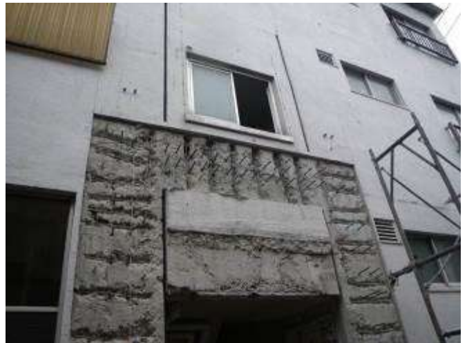
耐震スリット（上部）とあと施工アンカーが設置された補強フレーム設置箇所
