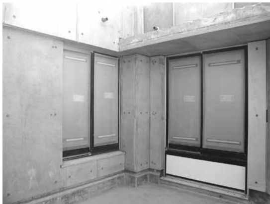
外壁・柱型、パラベットは断熱パネルで覆い、ルーフトラスアスファルト防水の上に断熱ブロックで覆う。
