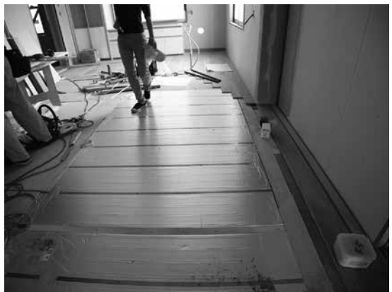
各ユニットの集まり部屋は温水床暖房パネルを敷き、無垢単板フローリング仕上とする。
