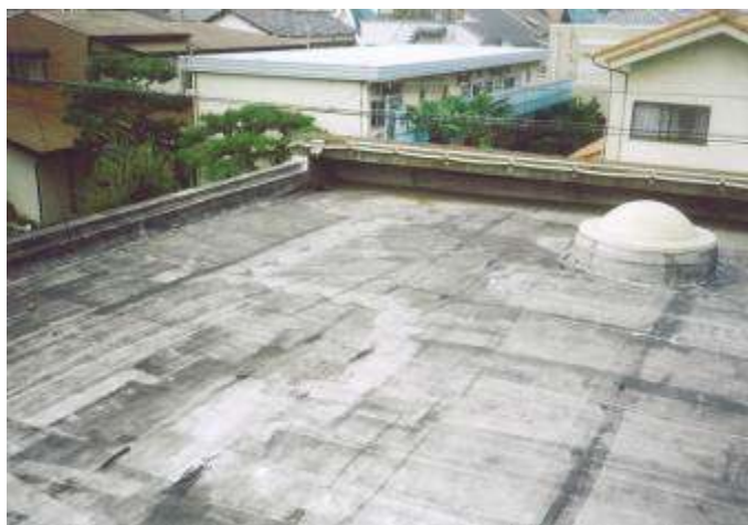
改修前の屋根 ほてりが激しく2階は使ってなかった。 アスファルト露出防水、トップライト廻りから漏水
