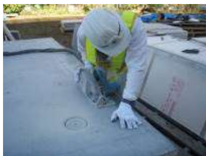
断熱パネルを加工する
