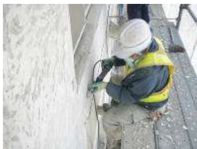
超音波剥離機で完全クレンする
