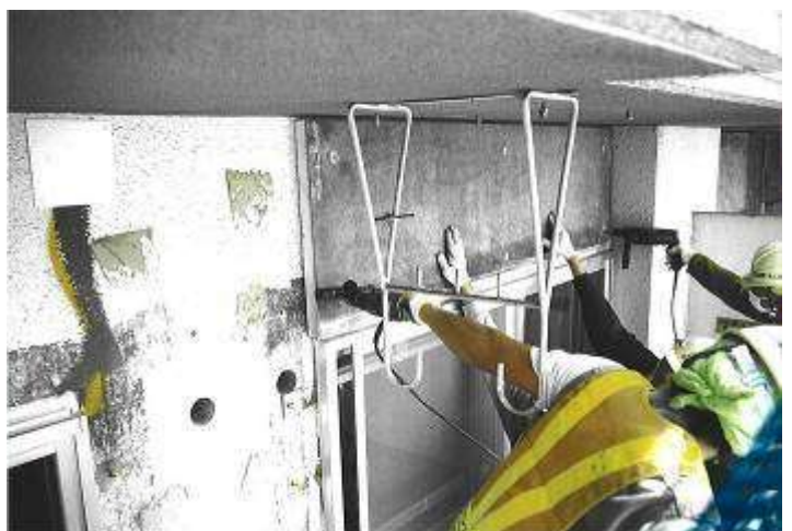
外壁面に押出発泡ポリスチレン(厚40mm)+GRC 複合の断熱パネル(北日本ダイエイ製)を張る。
