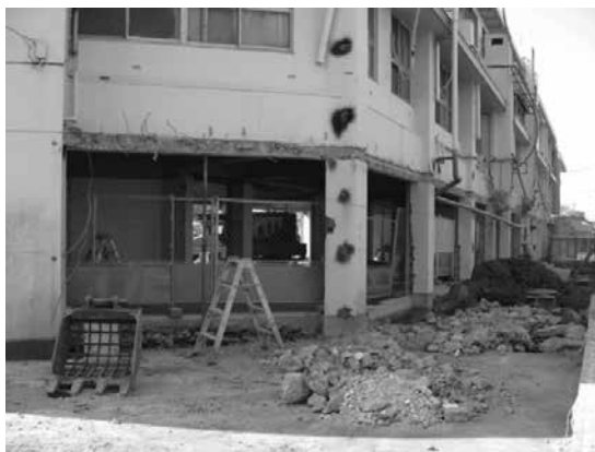
増築された建物を除却し、1階の内装材やサッシを除却する。1階工事中、2～3階で寮生が生活している
