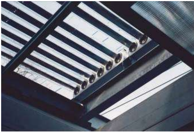
トッブライト上部の真空管集熱装置(ソーラーコレクター)
