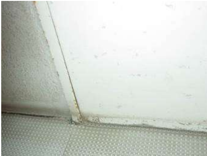
煙を感知しても閉鎖しない防火扉。扉の下部が腐食劣化し、扉が閉鎖しなくなる。枠・ヒューズ・扉とも更新する。
