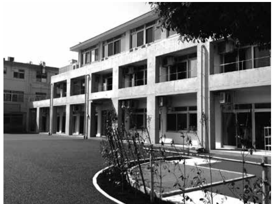
アウトフレームは室内空間を外部に向けて延長し、軒の出を深くしサンコントロール装置として活用する
