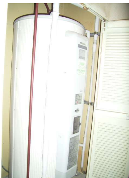
室内廊下側の扉と貯湯式給湯器。 85℃ 400ℓの熱湯の貯湯槽
