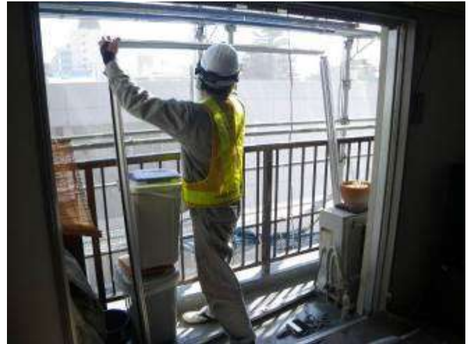
新しいアルミサッシ枠をバルコニーで組み立てる
