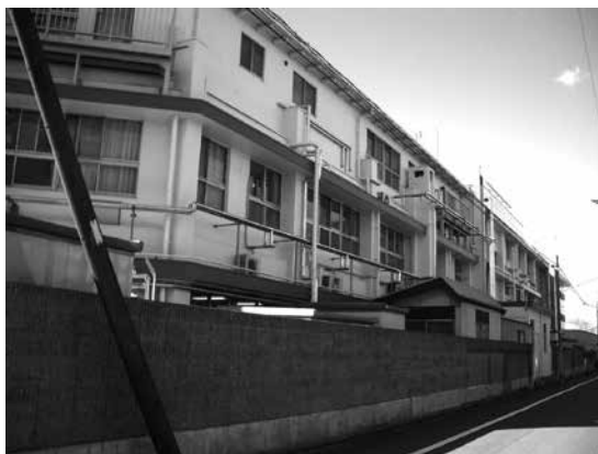
改修前の小百合の寮北側。ボイラー室や倉庫・食品庫などが増築され、外壁に設備配管が露出していた。
