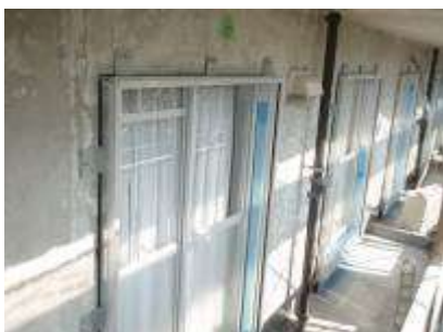
新規サッシを取付ける
