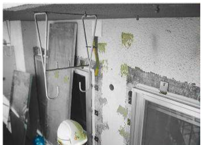
マンションの外壁に厚さ:50mmの外断熱パネル。掃出しサッシを二重化し、開口部からのヒートロスを防止する。
