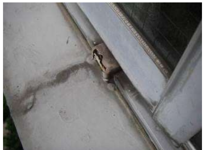
アルミサッシは樹脂部品、アルミ部材とも劣化が進行
