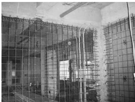
既存躯体に耐震補強壁を新設・補強し、大舎制を6つのユニットに分割する。
