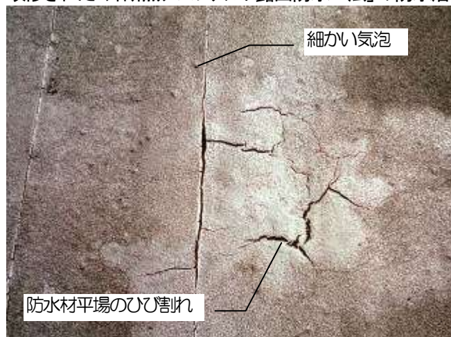
大屋根平場の防水材表層劣化状況
