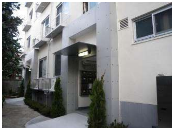
耐震フレームの施工後の状況
