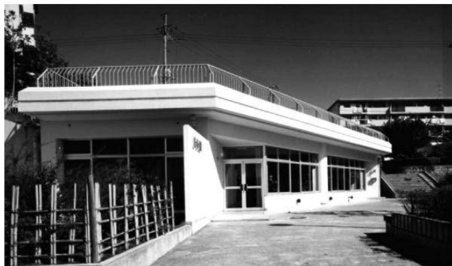
欠陥バルコニーのお見舞金で建てられた第2集会所。敷地は約1mほど下げ、屋上をルーフトラス状にしている。右手奥が第1集会所。
