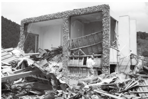
大船渡 赤崎の住宅地。RC造2階建て住宅が押し倒される。阪神大震災とは全く異なる風景を目にした。
