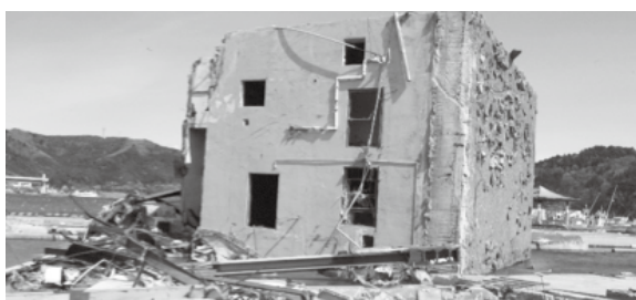
女川の海辺の転倒した3階建てビル。ベタ基礎。
