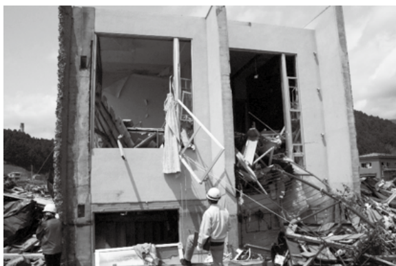
大船渡 赤崎の住宅地。RC造2階建て住宅が押し倒される。阪神大震災とは全く異なる風景を目にした。
