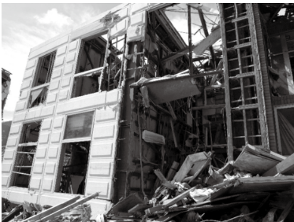
杭基礎の基礎梁と1階スラブが見える。外階段と反対側のファサード。1～2階が特に破壊されていた。
