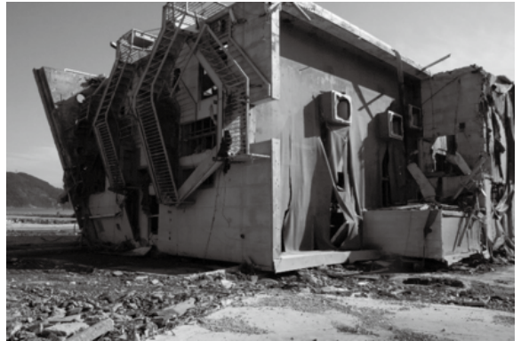
女川に建つ鉄骨造地上4階建て外階段付きPC杭の建物が横倒しになっていた。基礎の下がまるみえ。
