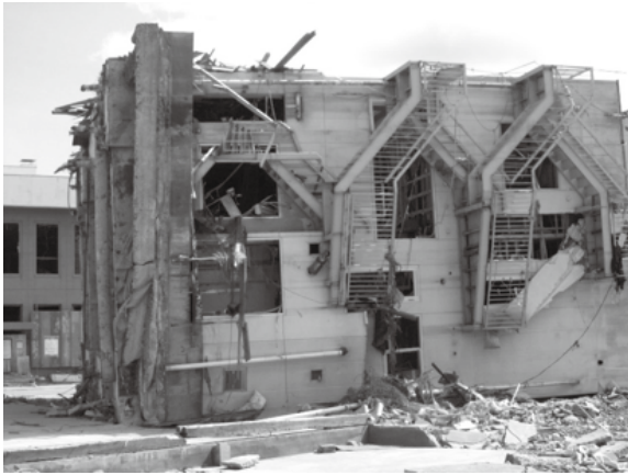
女川に建つ鉄骨造地上4階建て外階段付きPC杭の建物が横倒しになっていた。基礎の下がまるみえ。
