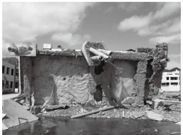
杭基礎の基礎梁と1階スラブが見える。外階段と反対側のファサード。1～2階が特に破壊されていた。
