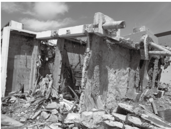
女川の鉄筋コンクリート・ラーメン構造 杭基礎。1～2階が津波で被害が激しい。
