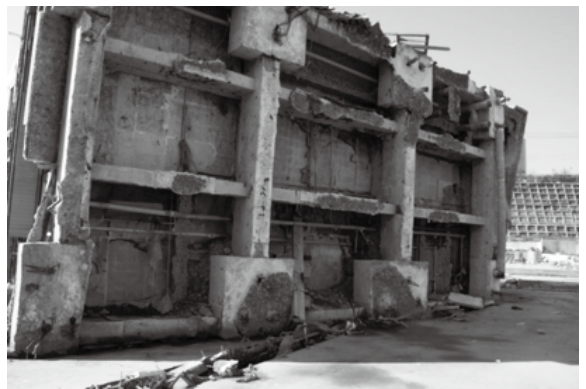
杭基礎の基礎梁と1階スラブが見える。外階段と反対側のファサード。1～2階が特に破壊されていた。
