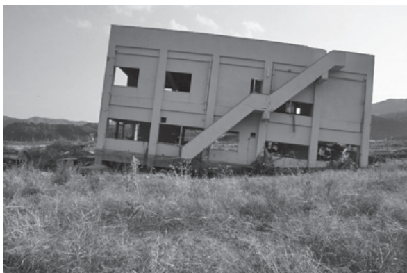
志津川の水門近くに建つ RC 造 2 階建ての建物。片側が深く洗掘され、傾いている。
