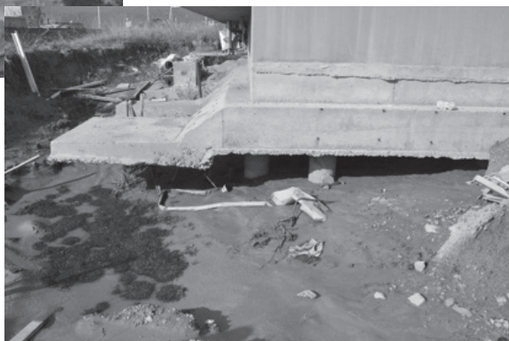
陸前高田の海岸近くに建っていた集合住宅の洗掘被害。1階妻壁の下部(基礎部)が津波に洗われ土砂が洗い流されている。
