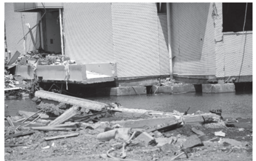
志津川病院の西側妻壁の洗掘。RC造5階建て。基礎部が洗掘。入院患者を屋上に避難させ翌日、多くが救出された。
