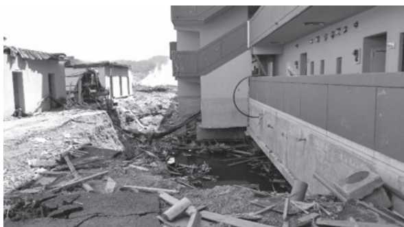
志津川の海辺の4階建RC造マンションの洗掘。建物の周りが洗掘により水溜まりとなっていた。この建物は杭の耐力で立っていると思われる。もし激しい直下型地震の揺れが加わったら倒壊するものと推定される。
