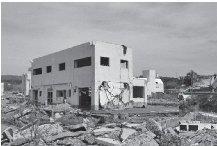
南側 1 階の妻壁に硬く大きな物体が激突したと思われる。 志津川の RC 造 2 階建て建物の洗掘被害。RC 造 2 階建てビル。 周辺が水溜まり
