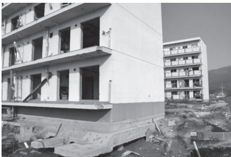
陸前高田の海岸近くに建っていた集合住宅の洗掘被害。1階妻壁の下部(基礎部)が津波に洗われ土砂が洗い流されている。
