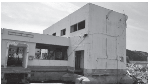
RC造2階建てビルの洗掘被害。志津川のRC造2階建てビル。
