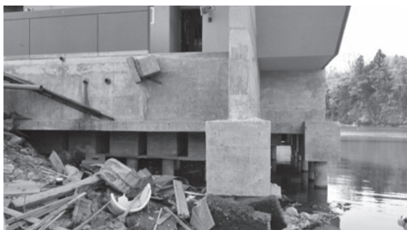
志津川の海辺の4階建RC造マンションの洗掘。建物の周りが洗掘により水溜まりとなっていた。この建物は杭の耐力で立っていると思われる。もし激しい直下型地震の揺れが加わったら倒壊するものと推定される。
