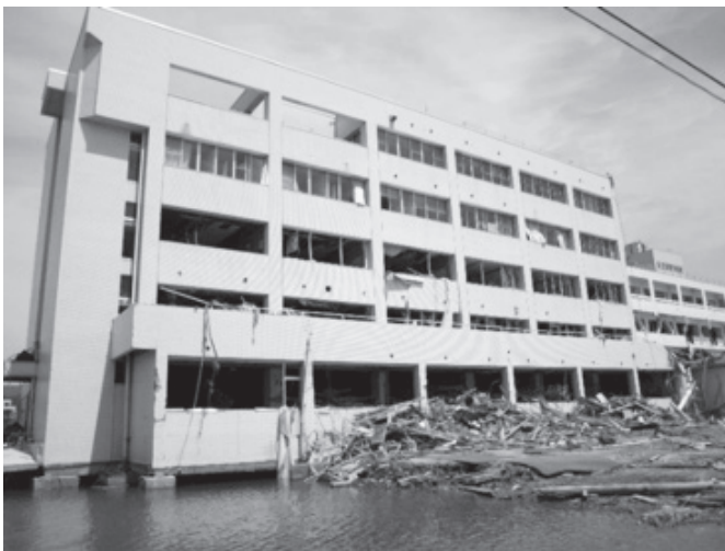
志津川病院の西側妻壁の洗掘。RC造5階建て。基礎部が洗掘。入院患者を屋上に避難させ翌日、多くが救出された。
