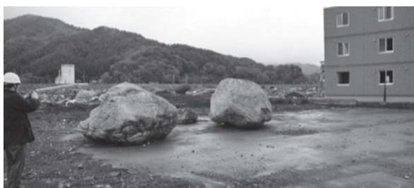
津波により海底から巻上げられ鉄筋コンクリート壁を破損した岩石。海底にあった岩石が津波で巻上げられ、移動して来て、2 階の外壁に衝突し、鉄筋コンクリート壁を破壊し損傷を与える。
