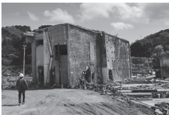
女川ではつなみの力で鉄筋コンクリート造2階建ての大型住宅が倒されていた。
