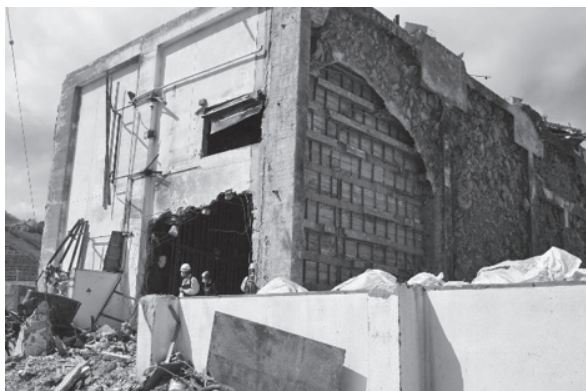
1 階床下は木造床組フローリングと推測され、洗堀の圧が見られないこと。津波で建物が浮き上がり押し倒されたと思われる。
