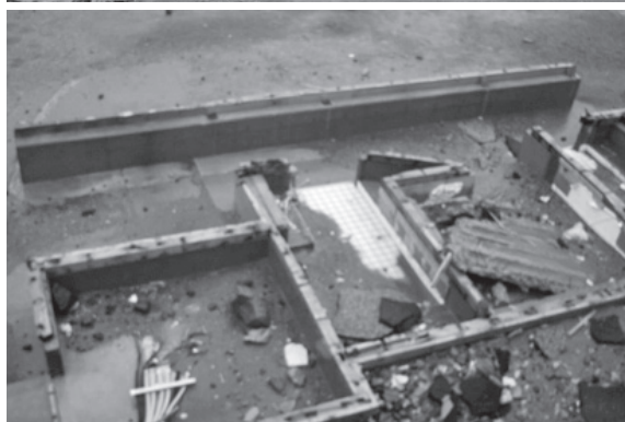
釜石市内の風景。基礎と土台が残り、木造住宅の上部構造は浮き上がり、浮遊物となり、やがて瓦礫になる。
