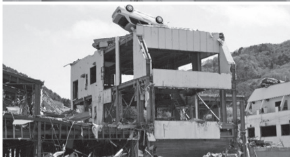
鉄筋コンクリート造のパラペット天端に漂着した木造家屋と鉄骨造3階屋根に流れ着いた自動車。女川
