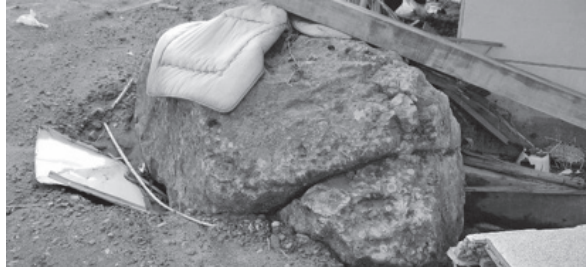
津波により海底から巻上げられ鉄筋コンクリート壁を破損した岩石。海底にあった岩石が津波で巻上げられ、移動して来て、2 階の外壁に衝突し、鉄筋コンクリート壁を破壊し損傷を与える。
