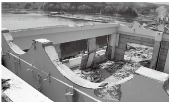
写真左側が在来工法屋根スラブ。右側の弧にえぐれた壁梁はシルバークールを受ける。
