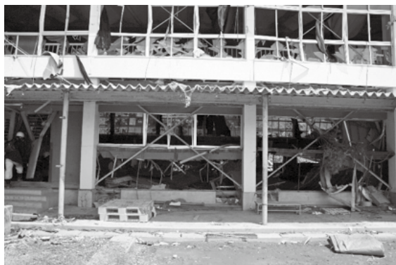
体育館の校庭側サッシの被害状況。舞台裏側外壁ほど激しく壊れてはいない。
