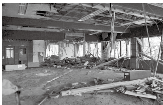
同じく東棟事務室内部の津波被害。木造間仕切りや天井仕上材がなくなっている。
