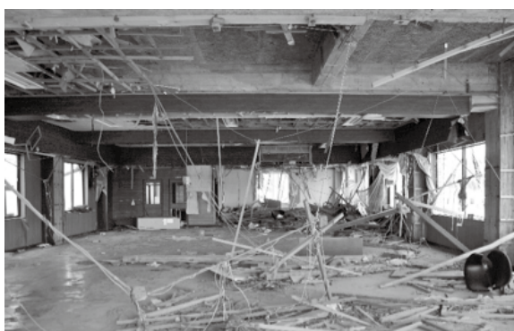
東棟事務室内部、木造間仕切り壁を破り、窓サッシを破る。室内に充満した津波は窓から外に。
