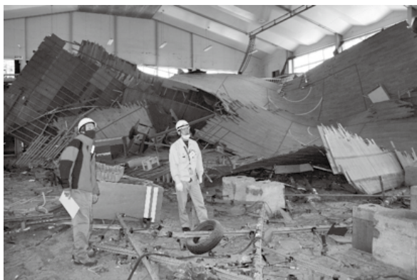
海面より一段高い位置に建つ大船渡市立赤崎中学校の鉄骨造の体育館。舞台裏の外壁を破って床下に侵入した津波は軽量鉄骨長尺根太の上に構造用合板が張られ、木製フローリングを捲り上げていた。
