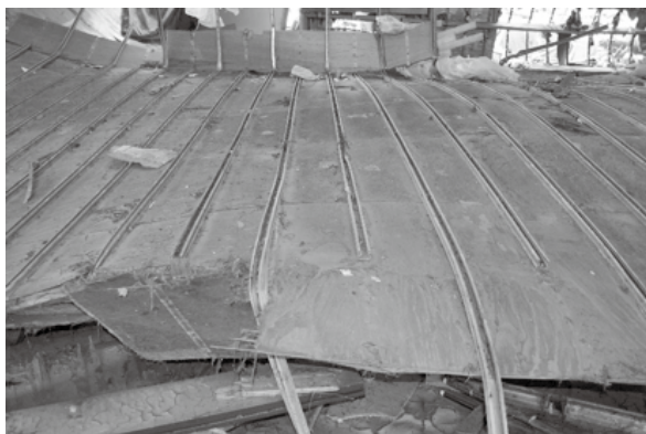
体育館の床は軽量鉄骨大引き下地の上に構造用合板を敷き、フローリングが敷き詰められている。舞台裏から侵入した津波は、床下に入り、フローリング床下地材とも持ち上げ、めくり上げてしまったと思われる。
