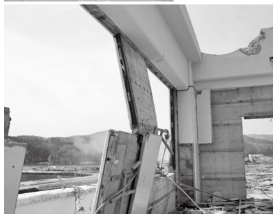
西側大空間の海側開口の帳壁。津波の力で室内側に押し曲げられている。
