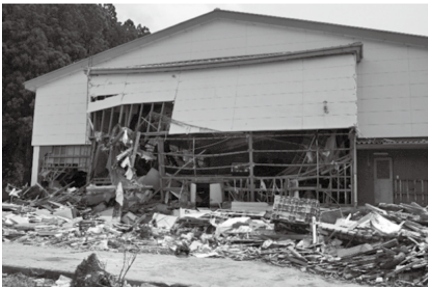
中学校体育館の舞台裏の外壁が津波で破れていた。
