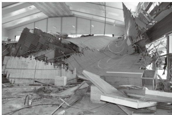
海面より一段高い位置に建つ大船渡市立赤崎中学校の鉄骨造の体育館。舞台裏の外壁を破って床下に侵入した津波は軽量鉄骨長尺根太の上に構造用合板が張られ、木製フローリングを捲り上げていた。
