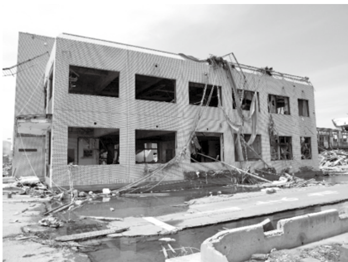
2階建ての東側ファサード。屋根スラブは在来工法
