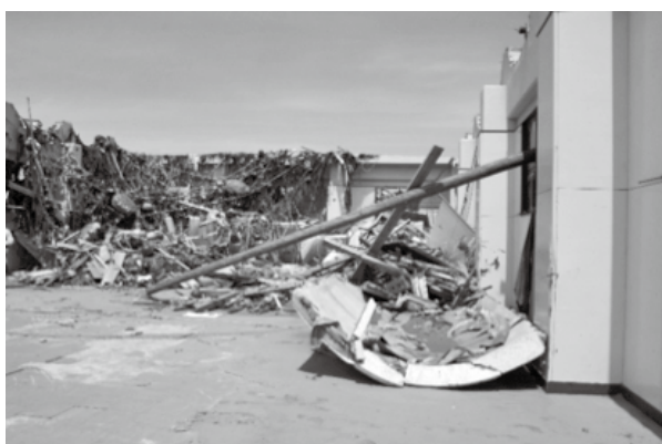
屋根がなくなった西棟会議室。右下が PC 屋根板。2 階大空間を満杯にした津波は屋根板を持ち上げ山側に押し遣ったと思われる。
