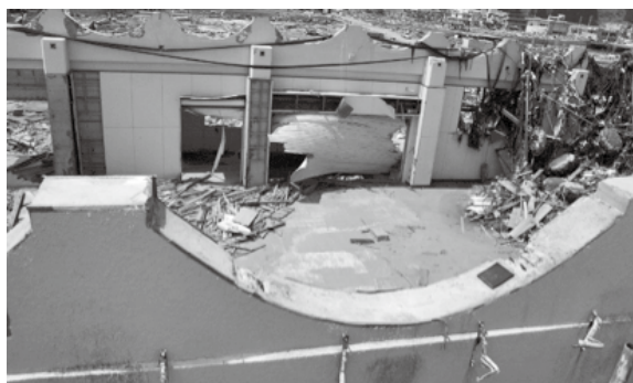
津波によりシルバークール屋根がなくなった状況。手前はシルバークール受け壁梁の詳細。津波の持ち上げる力で、PC 屋根板が浮きあげられたか？
