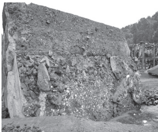
基礎は杭基礎ではなく、置き基礎(ベタ基礎)。 鉄筋コンクリート造の防潮堤の支持地盤の山側で津波が支持地盤をえぐり取り、洗掘が進行し、巨大なコンクリート構造物が傾斜し、転倒、或いは移動したと思われる。
