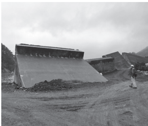
釜石市両石の防潮堤。津波は鉄筋コンクリート造の防潮堤の周りの地盤を洗掘し、鉄筋コンクリート造の防潮堤を傾斜させ、転倒させている。
