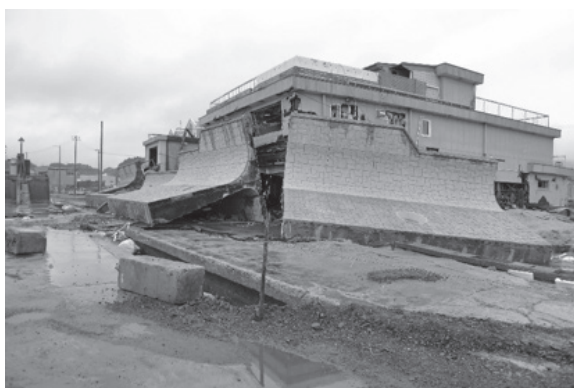
建物廻りに引き寄せられた防潮堤の上部構造
