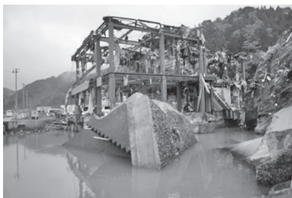
防潮堤の内側に鉄骨造 2 階建ての建物が建つ。洗掘により基礎がむき出しになり内外装仕上材や床スラブ、屋根スラブは無くなっていた。屋上に小型ボートが引っ掛かっていた。
