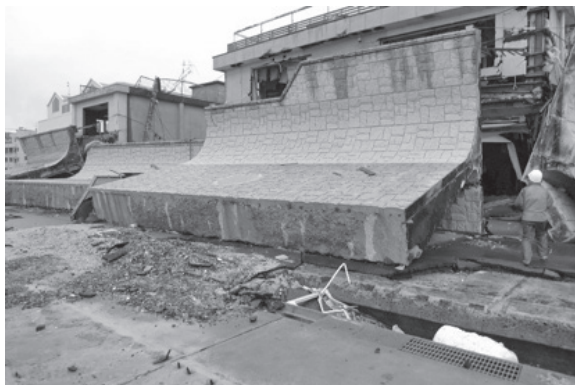
防潮堤の上部構造は打ち継ぎ部で切断され、遠く離れた建物廻りに津波の力で運ばれた。
