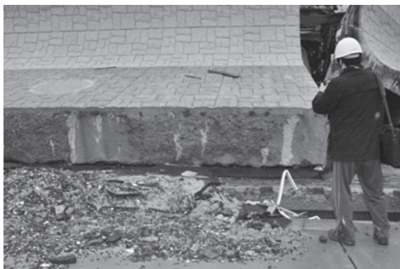
防潮堤の厚さ6～70cmの壁が、打ち継ぎ部で切断され、10 m以上移動している。
