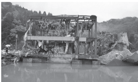
漁港の管理事務所か？ 防潮堤の山側が洗掘によりえぐり取られ、鉄骨造 2 階建ての建物の基礎の地盤もえぐり取られている。この鉄骨造 2 階建ての建物は杭基礎ではなく直接(ベタ)基礎と思われる。若干、画面の右側に傾斜しているようだ。
