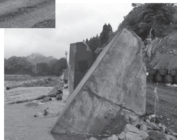
釜石市両石の防潮堤。津波は鉄筋コンクリート造の防潮堤の周りの地盤を洗掘し、鉄筋コンクリート造の防潮堤を傾斜させ、転倒させている。
