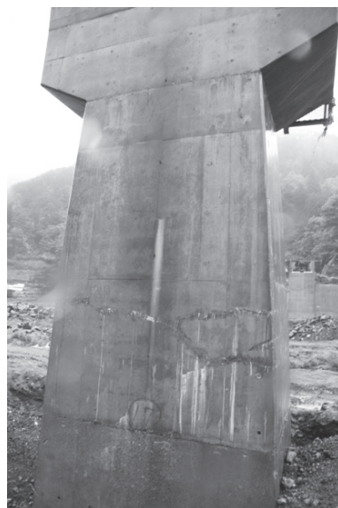
津波に流されなかった松前川を渡る橋梁の支柱。この支柱は杭基礎であったため津波に流されなかったと判断される。
