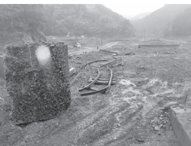
津波に流されなかった松前川を渡る橋梁の支柱。この支柱は杭基礎であったため津波に流されなかったと判断される。
