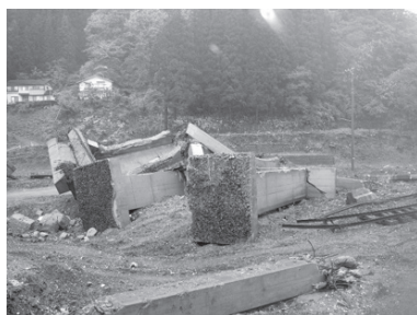
橋梁の支柱は杭なしの置き基礎で津波で転倒した。
