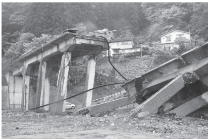
2011年3月11日の島越駅の津波被害状況。トンネルを出ると高架橋の上を鉄道の線路が走る。トンネルより高い位置に建っていた民家は津波被害は見られない。トンネルより低い位置に建つ民家は全てなくなっている。
