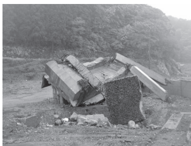
高架橋の支柱、鉄道線路とも流失する。
