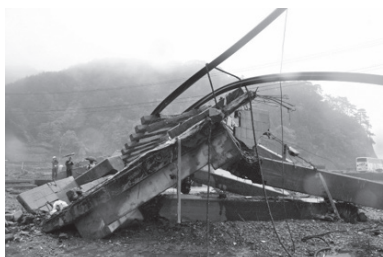
高架橋の支柱、鉄道の線路とも壊れてしまった。
