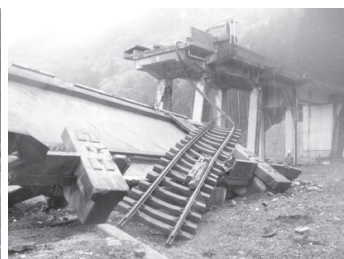
鉄筋コンクリート造の橋脚は津波により転倒している。橋脚は杭のない置き基礎であった。
