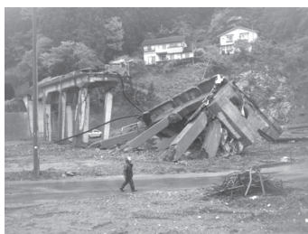
鉄筋コンクリート造の橋脚は津波により転倒している。橋脚は杭のない置き基礎であった。
