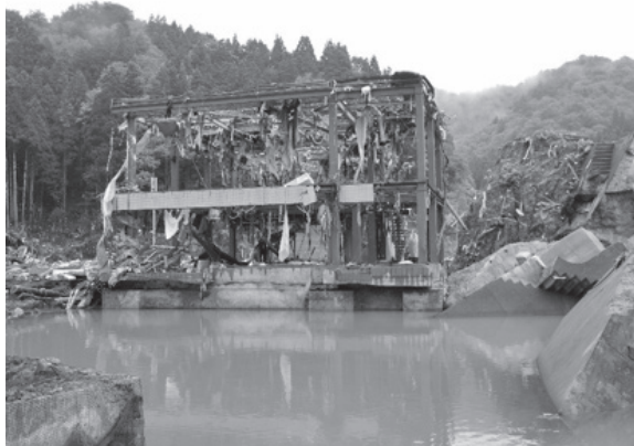
鉄骨造建物は内外装仕上げ材や天井屋根根材が無くなってしまい、スケルトンのみが残置される。
