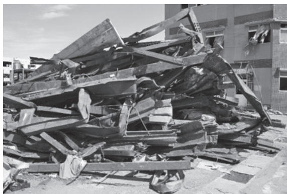
津波でバラバラになった鉄骨造建物
