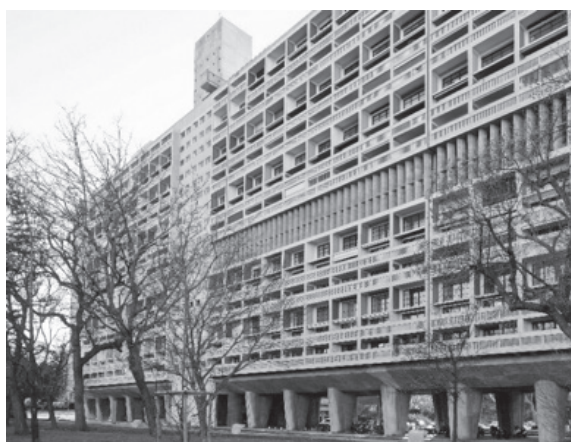
ル・コルビジエ設計のアパート。 巨大な津波は1階のピロティーを通り抜けてしまい 建物の基礎廻りの地盤を掘り洗掘することはない。
