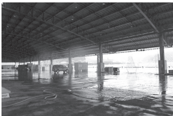
魚河岸の写真。壁がなく柱だけで構成される建物は津波が突き抜け被害がない。
