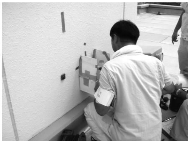
劣化調査の風景
