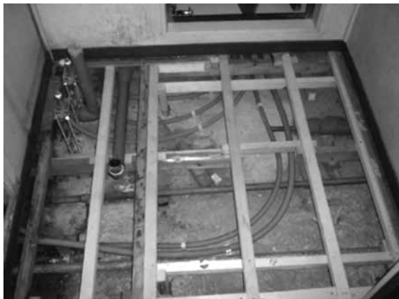
専有部分：洗面脱衣室床下の給排水給湯配管更新工事
