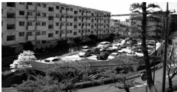
2階建ての高耐久コンクリート造・自走式駐車場。
