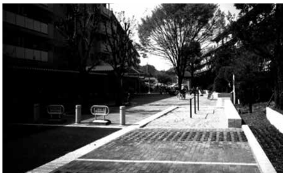
タマリユ混植の駐車場車室のレンガ舗装。 プレイロットはレンガ舗装とし、レンガベンチで囲み、樺の根元は 鋳鉄製ツリーサークルで保護する。
