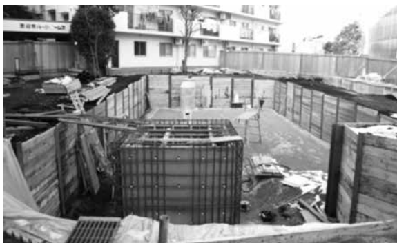
敷地の一部を約2m掘削し、地中に120m 3 の雨水貯留槽を地中に移設する。
