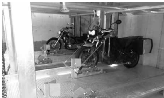
機械式駐車装置の下段のパレットに設置されたオートバイ専用の駐輪装置。1パレットに2台のオートバイが駐輪可能で、地震時に転倒せず、防犯にもなる。
