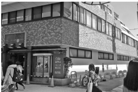
改修後の外観。1階右側の3構面に鉄骨ブレース補強がされ、排煙窓が設置されている。断熱サッシに更新された。
