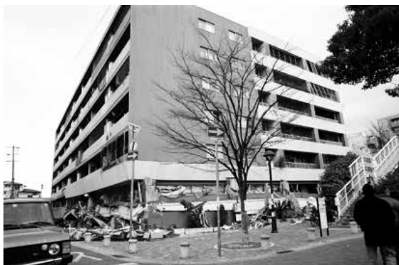
市街地型下駄ばきマンションの地震被害 上層階の集合住宅には被害が見られず、2階・施設階が総崩壊している。
