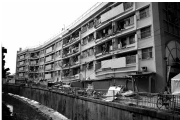
阪神大震災で被災した下駄ばきマンション。 地上5階建ての1階の左側が層崩壊している。
