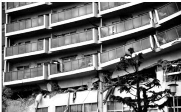
1～3階が店舗事務所等に使われていた西宮の高層の下駄ばきマンション。阪神大震災では3階が層崩壊した。
